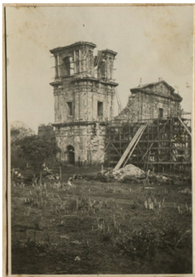
Figura 2 – Fotografia das obras realizadas pelo governo Borges de Medeiros. Inventário. Arquivo Central do IPHAN-RJ.
