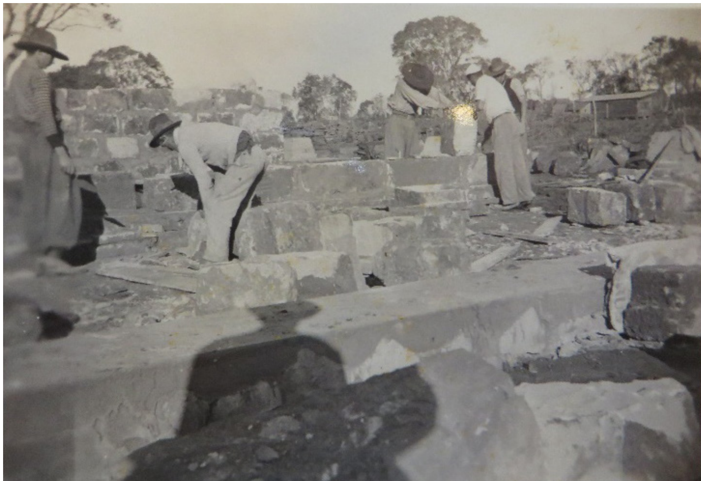
Figura 4 – Operários trabalhando nas obras de construção do Museu das Missões. Acervo do Arquivo Central do IPHAN – RJ.
