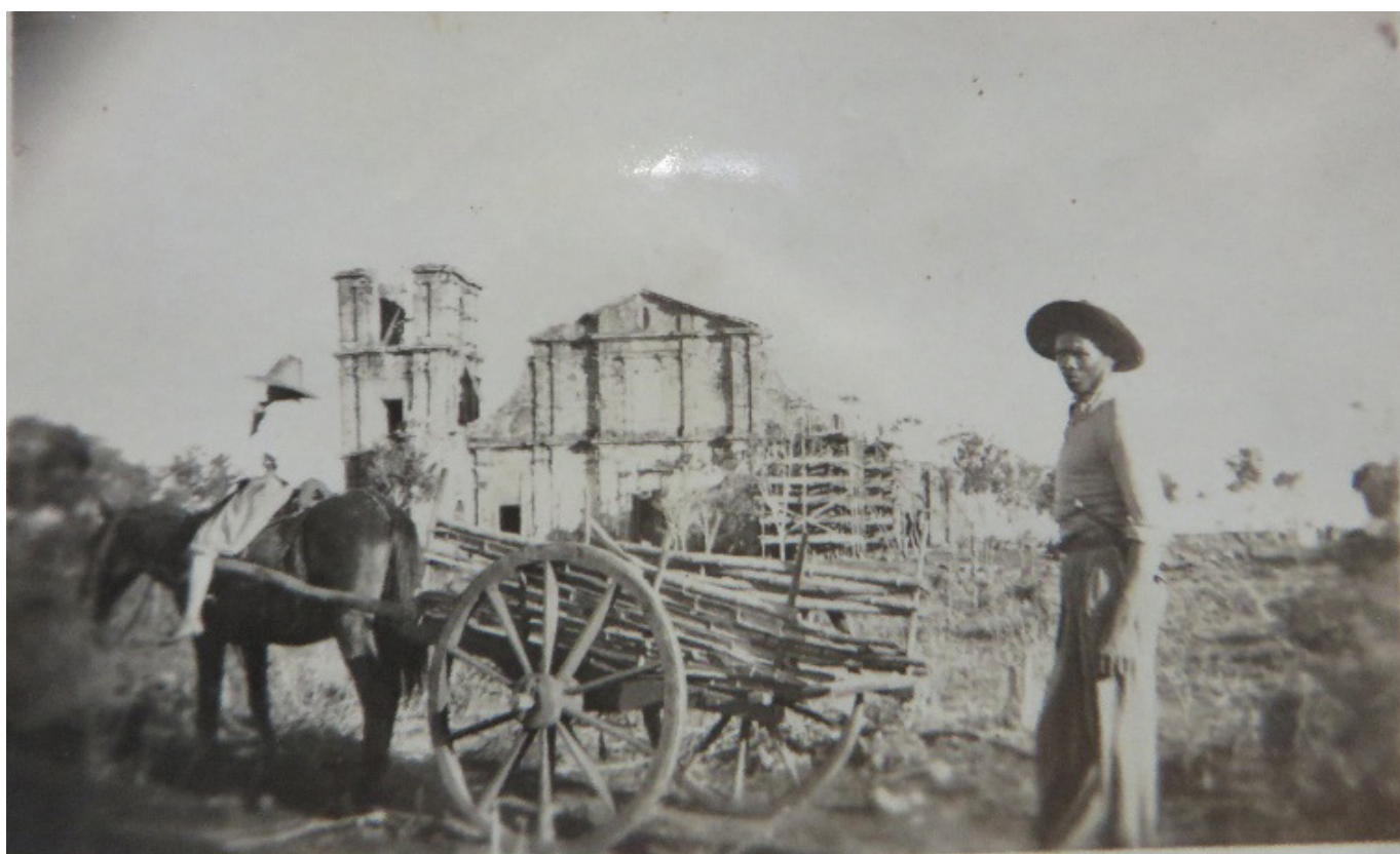
Figura 5 – Operários trabalhando nas obras de construção do Museu das Missões. Acervo do Arquivo Central do IPHAN – RJ.
